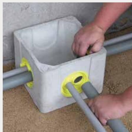
Dans le cas d'une boîte équipée de sa rehausse, pré-coller la boîte avec un joint mastic colle.
