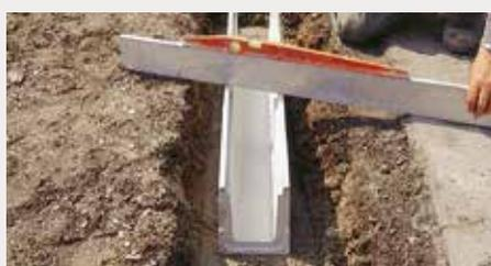
Poser le caniveau sur le lit de béton et régler le niveau transversalement. Aligner les éléments entre eux et régler la pente longitudinale. Réaliser un joint d'étanchéité au mastic colle entre chaque élément.
