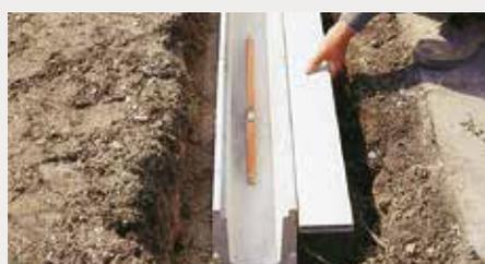
Comblir l'espace entre le caniveau et la tranchée avec du béton.
