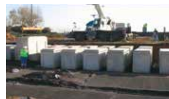
Fond de forme drainant : adapté sur les sites où le drainage ne peut être réalisé de part la configuration du terrain.
