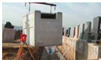
Longrine coulée en place : adaptée à la pose en escalier et courbes.
